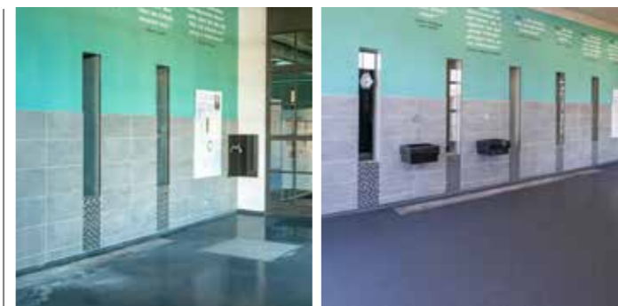
Der Boden des Selterswassermuseums im mittelhessischen Niederselters – vor und nach der Sanierung. Der teure und aufwendige Austausch des Belags konnte vermieden werden.
